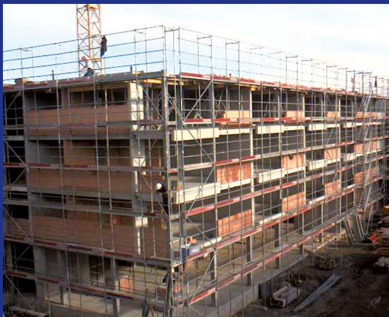
Aktuelle Aufnahme der Bauarbeiten Casa Güpf
