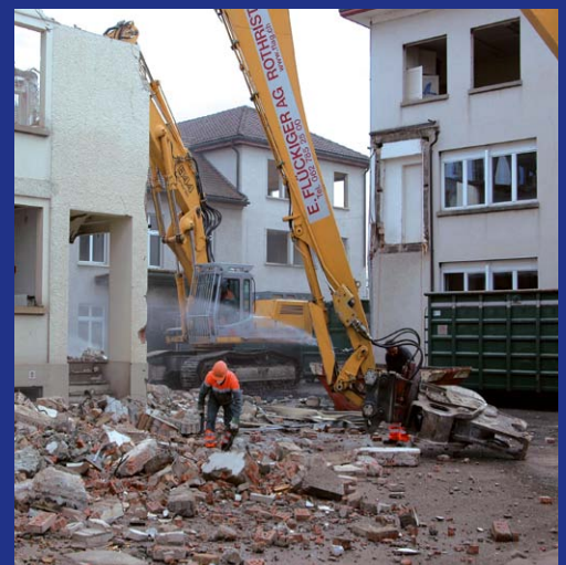
Während des Spatenstichs zur neuen Überbauung waren die Abbrucharbeiten der alten Howag-Gebäude in vollem Gang. Für die Casa Güpf wird mit einer Bauzeit von 18 Monaten gerechnet.
