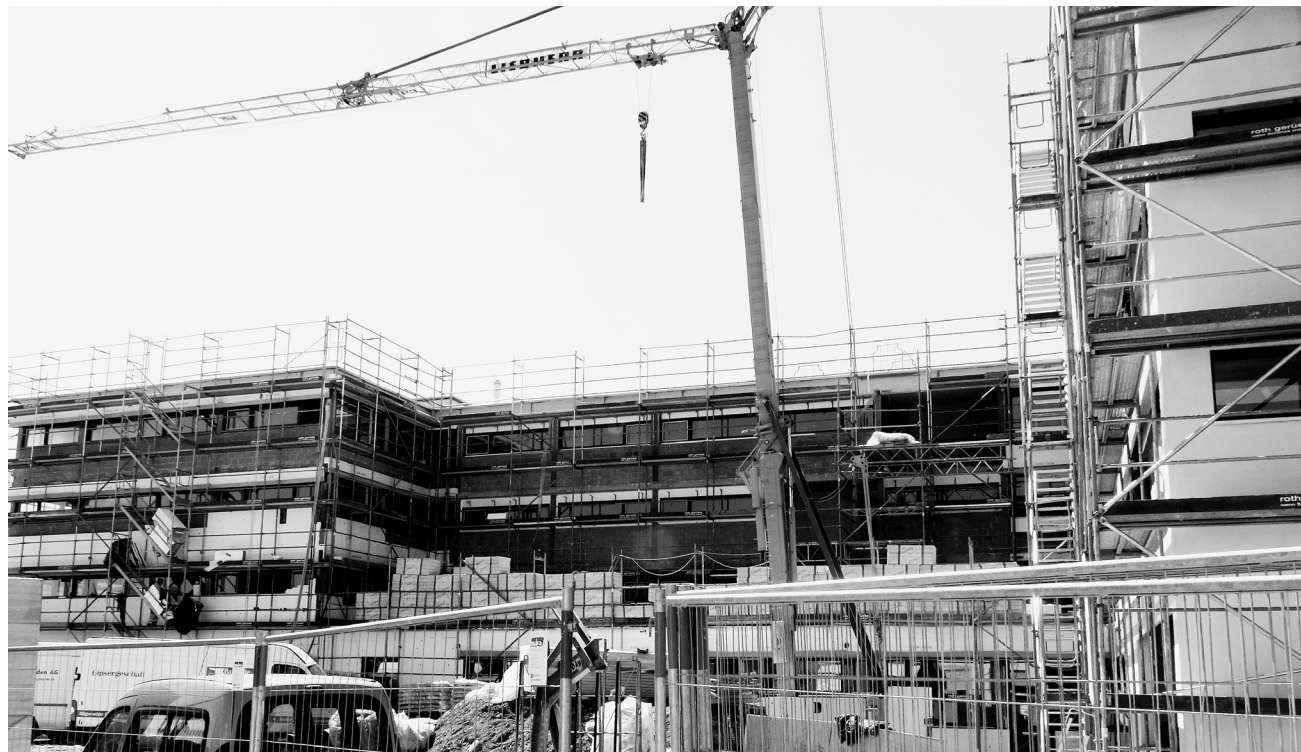
Seit knapp einem Jahr im Bau: Die Casa Güpf an der Zentralstrasse kommt gut voran, Anfang Oktober soll die Einweihung erfolgen.
